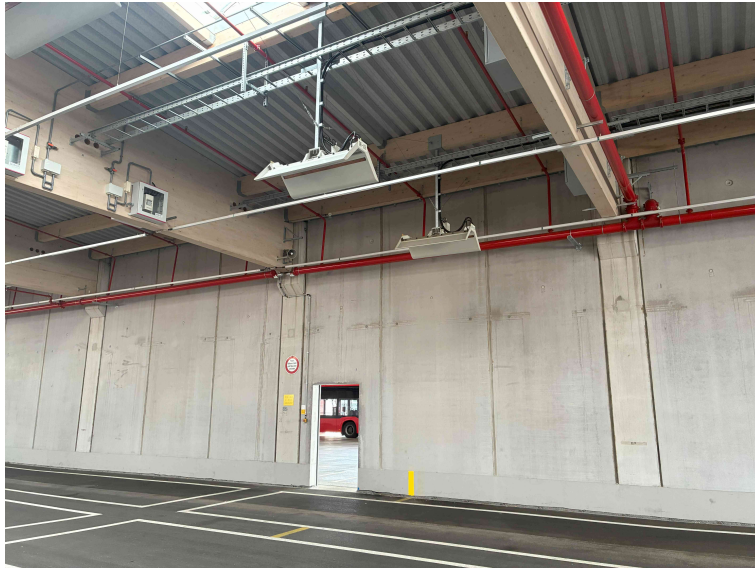
Ansicht Innen West an Betonwand
